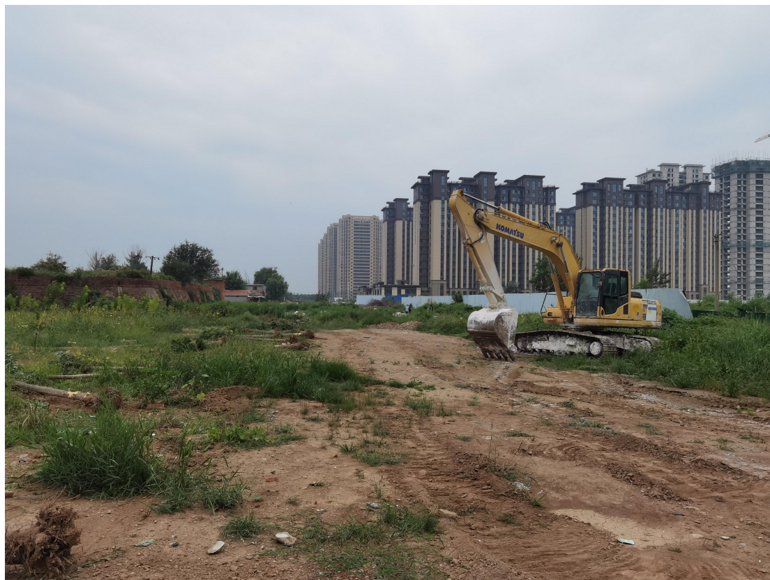
照片 2-2 项目区现场照片
